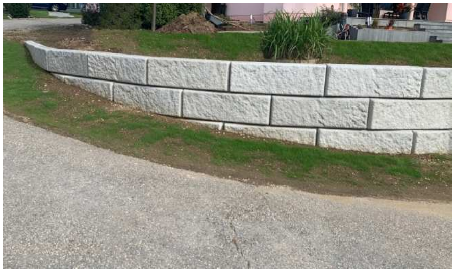
Ausführung einer kurvigen Stützmauer
