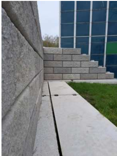
Ausführung einer Innen- und Außenecke
