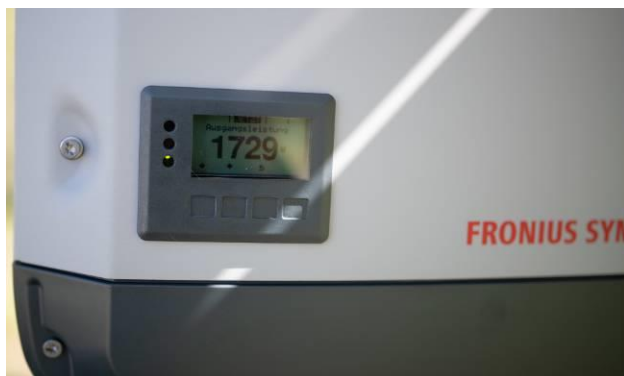
Bild 4: Display Wechselrichter, links mit den Kontrolllampen
